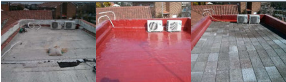
Madrid Pozuelo de Alarcón Impermeabilización y aislamiento de vivienda
