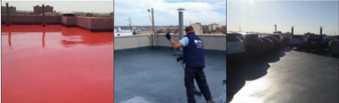
Madrid C/ General Ricardos Impermeabilización y revestimiento transitable en aparcamiento de vehículos
