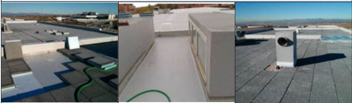
Madrid Paracuellos del Jarama Impermeabilización cubierta en colegio
