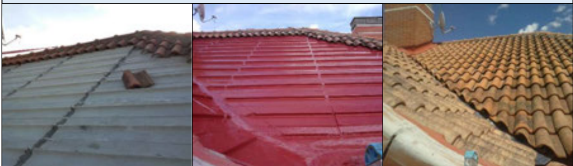
Madrid S.S. De los Reyes Impermeabilización y retejado de vivienda unifamiliar
